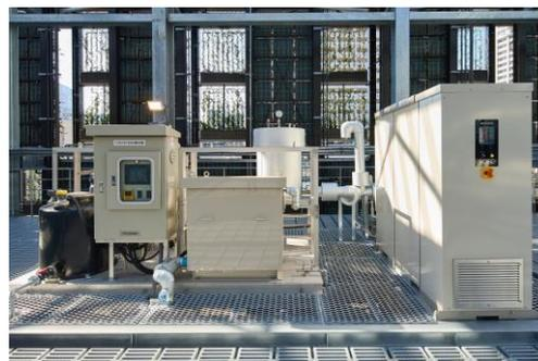
高効率燃料電池システム FC-6MとCCU装置
